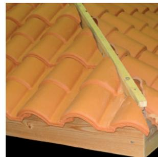
**4** Remettre les tuiles tronçonnées repérées à l'étape 2. Fixer au mastic élastomère les tuiles ayant perdu un tenon. S'assurer que les tuiles coupées soient orientées dans le sens de la pente pour ne pas guider l'eau vers l'arêtier.
