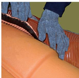
**6** Marouflage des bavettes du closoir souple ventilé LAHE-ROLL suivant l'onde de la tuile.
