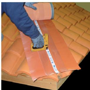
**5** Closoir souple ventilé LAHE-ROLL. La pose débute par le bas de l'arêtier. Le closoir est déroulé progressivement. Des agrafes (ou pointes) permettent sa fixation sur la lisse de réhausse.
