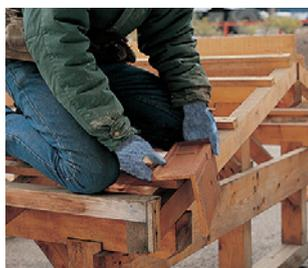
**1** Une cale à l'égout, de l'épaisseur d'une rive, permet d'aligner correctement la première rive.
