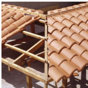
**2** Tronçonner les tuiles suivant cette ligne. Les déposer et les mettre en réserve (il est conseillé de les numérotter pour les identifier plus facilement pour la repose).
