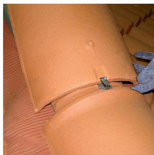
**7** Engager les arêtiers dans les clips éventuels et progresser jusqu'au faîtage en fixant systématiquement les arêtiers.
