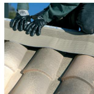
**4** Plier le closoir Lahe-Roll sur les tuiles en se servant des plis préformés et comprimer la bavette uniformément dans le courant des tuiles de 2 côtés de la rehausse. Veiller à ne pas trop presser la partie centrale perforée sur la rehausse afin de ne pas diminuer la capacité de ventilation.
