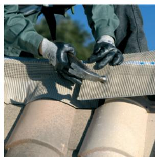
**7** Les raccords doivent être faits en recouvrant les extrémités de 5 cm. À l'extrémité du faîtage ou de l'arête, couper le closoir rouleau avec des ciseaux ou un cutter. La chute peut être réutilisée lors d'un prochain chantier.
