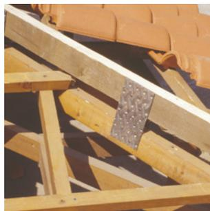
**3** Clouer la lisse de réhausse dans l'axe de l'arêtier. Il est possible de compléter la fixation à l'aide de supports galvanisés à jambes réglables.
