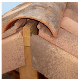
**3** Les faîtières à emboîtement sont ensuite posées et fixées sur la lisse de faîtage. Un fronton dédié au type de rives utilisées viendra terminer l'ouvrage.
