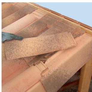
**2** La finition en rive s'effectue à l'aide de la sous-faîtière rive droite ou de double de rive sous-faîtière en fonction des modèles de tuiles. Il convient de fixer cet accessoire avec du mastic élastomère ou par vissage/clouage.
