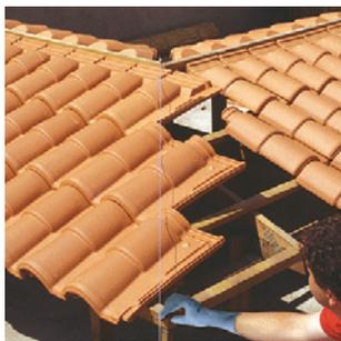
**1** Mettre en place les tuiles du premier versant au delà de l'axe de l'arêtier. Tracer au cordex le trançhis, à 3 cm en retrait de l'axe de l'arêtier.
