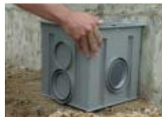
**3** Mettre en place le regard dans l'axe de la descente E.P. Éventuellement le surmonter d'une ou plusieurs réhausses.
