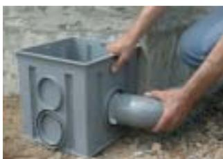
**4** Raccorder les entrées éventuelles et sorties. On peut par faire l'étanchéité par un joint de mastic silicone.
