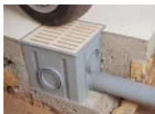
**8** Bétonner pour une résistance jusqu'à 1,5 T par roue avec tampon ou grille.
