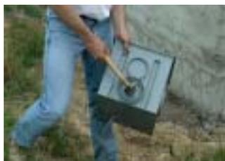
**2** Dégager au marteau les emboîtures à utiliser.
