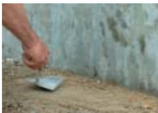
**1** En fonction du niveau des évacuations et du sol fini, établir une base en sable damé ou béton maigre.
