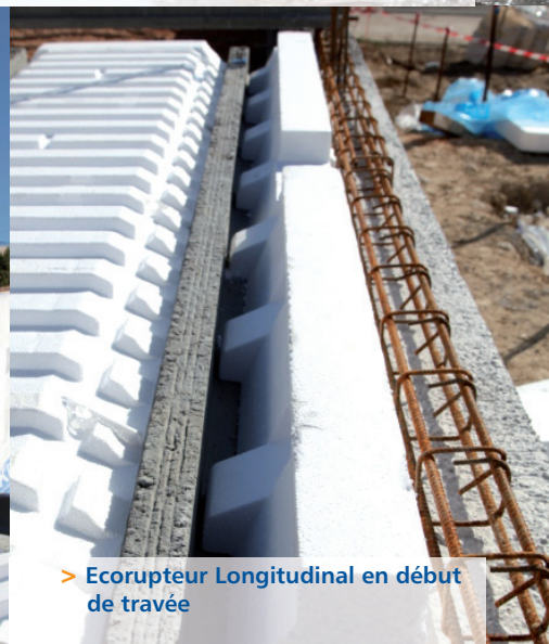
> Réalisation des travées démodulées facilitée grâce à l'Isoleader Modulo (entaxe < 60 cm)
