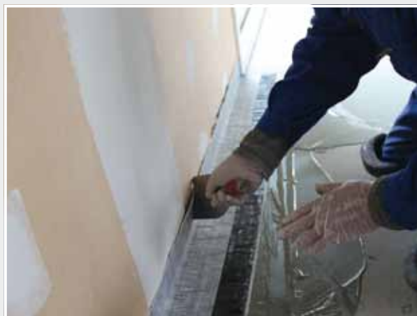
Pose de la PRB Bande SM 200 (extérieur & intérieur)
