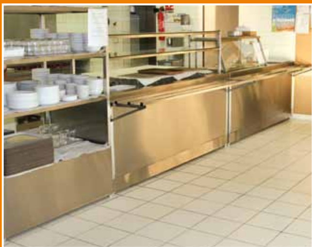
Étanchéité des cuisines collectives
