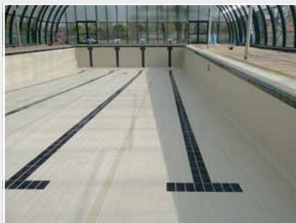
Étanchéité des bassins
