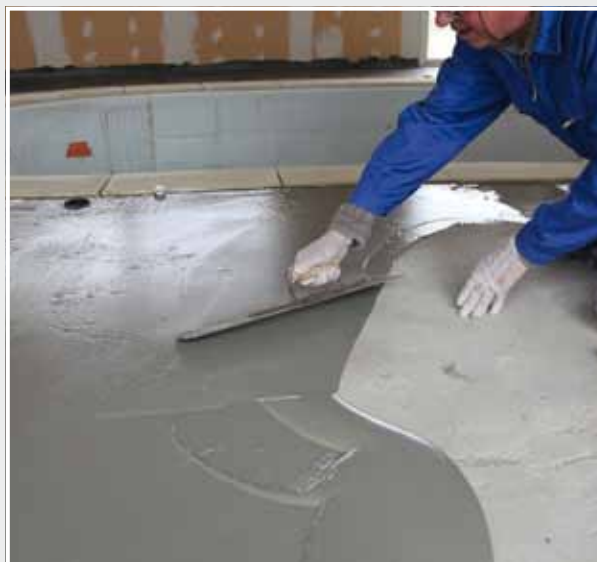
Étanchéité des plages
