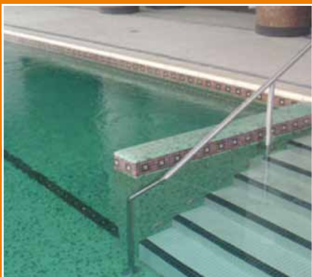
Étanchéité des bassins
