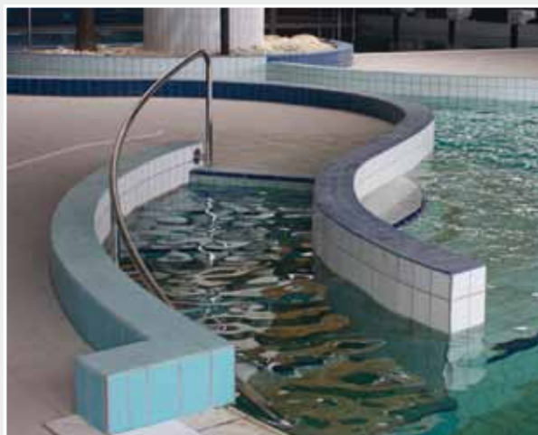
Étanchéité des bassins
