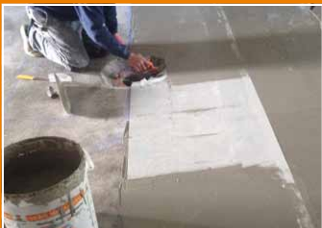
Pose du treillis ARMACEL en continu
