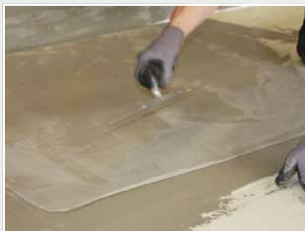
Pose du Treillis ARMACEL en Bande ou en continu
