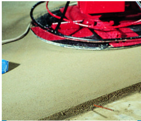
Power floating the surface of a Finition à l'hélicoptèrescreed
