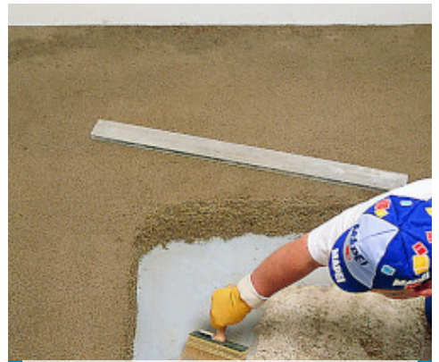
Application de la barbotine d'accrochage pour chape adhérente Topcem
