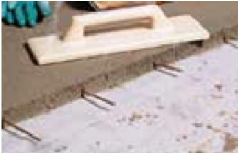
Préparation de la barbotine d'accrochage composée de Topcem et de Planicrete Latex
