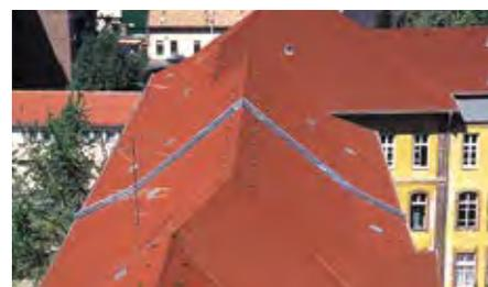
La mise en œuvre s'effectue sur des toitures de pentes supérieures à 20 % selon les indications du D.T.U 40.14.
