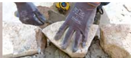
Maçonnerie de pierre
