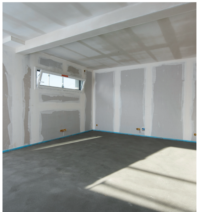
Maison Optima - Hagental le bas (68) - Mise en œuvre de la chape hydraulique
