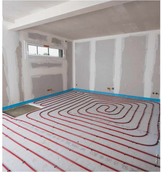
Maison Optima - Hagental le bas (68) - Mise en œuvre de la bande de rive Knauf Périmousse et du plancher chauffant
