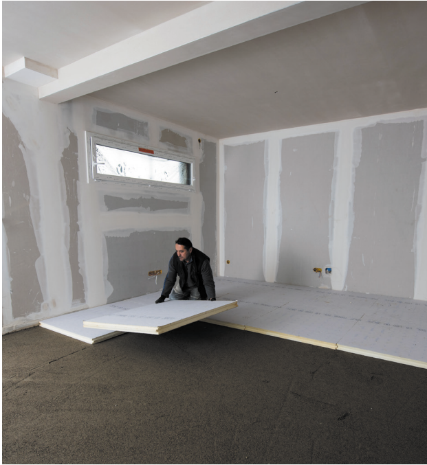
Maison Optima - Hagental le bas (68) - Mise en œuvre des panneaux Knauf Thane Sol sur la couche de ravaillage
