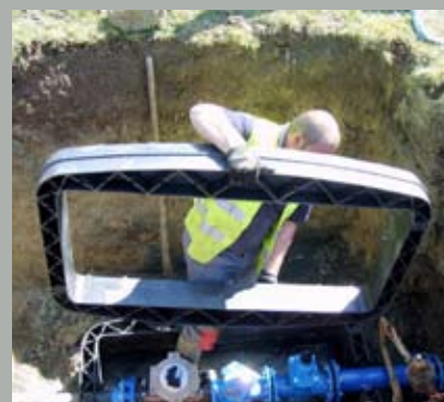
MISE EN PLACE DES ELEMENTS
