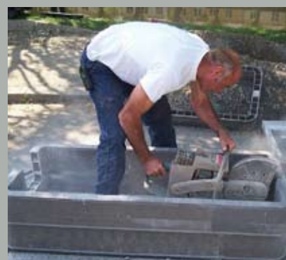
DECOUPES ET PERCAGES POUR ENTRES DE CANALISATION
