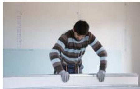
1. Encoller les fourrures Up Stil® 269 sur chacun des côtés du bloc PSE Up Stil® (à l'aide d'une mousse PU ou de colle silicone)
