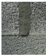
De 3 mm à 5 cm Remplissage au mortier
