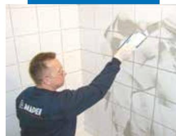
Jointoiement du carrelage avec le mortier joint Ultracolor Plus
