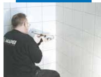
Réalisation des finitions avec le mastic silicone acétique Mapesil AC
