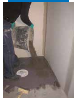
Réalisation de la forme de pente
