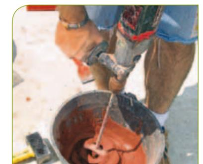
**1** - Réalisation du premier rang au mortier traditionnel hydrofugé (ép. 2 cm), à l'aide de platines d'aide à la réalisation de l'arase. Attention, le premier rang doit être d'une planéité parfaite.
