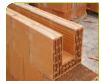
**2** - Pose de la brique **mono'mur** en partie courante : exclusivement au mortier Joint Mince, déposé à l'aide du rouleau applicateur.
