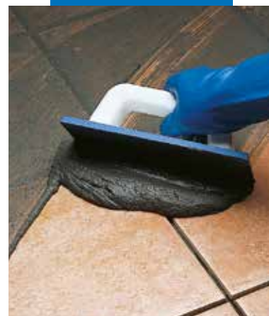
Jointoiment entre carreaux de grès émaillé, à la spatule
