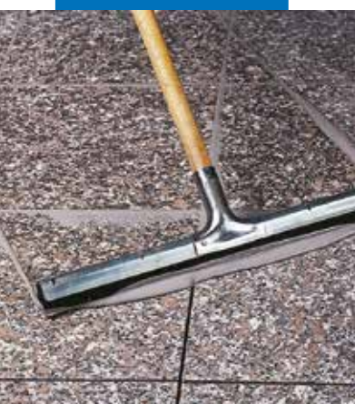
Jointoiement de granit à la raclette
