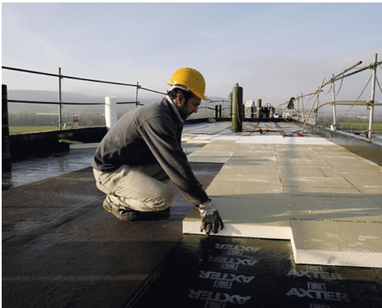
Pose libre des panneaux Knauf Thane ET sur le pare-vapeur.
