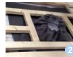
2 Colerette d'étanchéité pour écran de sous-toiture.
