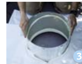
3 Colerette pare-vapeur d'étanchéité à l'air.
