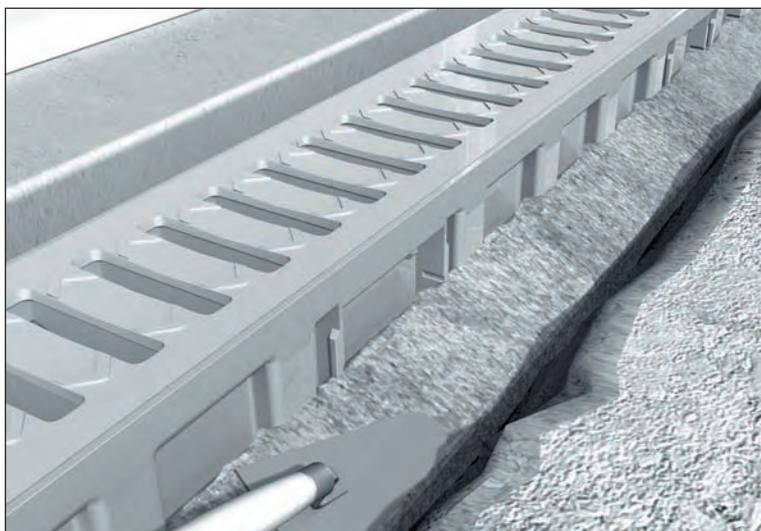
Réaliser le talutage béton comme recommandé sur les schémas d'installation par classe et type. Remblayer et faire les finitions en positionnant le sol fini entre 3 et 5 mm au-dessus de la grille de caniveau.
