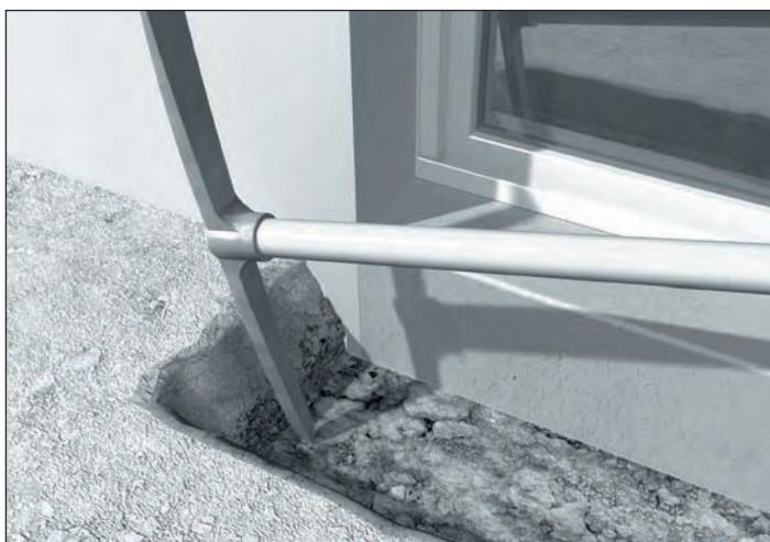
Réaliser une tranchée suffisamment profonde pour pouvoir installer le caniveau et la semelle béton (l'épaisseur de la semelle est donnée dans les schémas d'installation par classe et par type,
