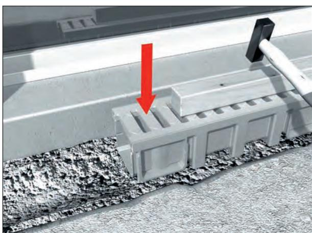
Enfoncer le caniveau de quelques mm pour l'amener en appui sur la semelle béton sur toute sa face inférieure.
