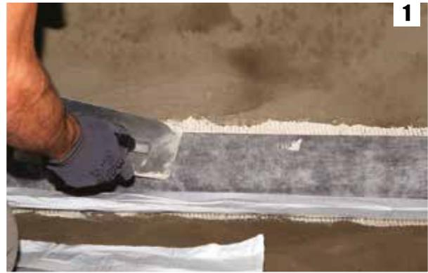
Collage de la Bande d'étanchéité SM 200 dans les angles
