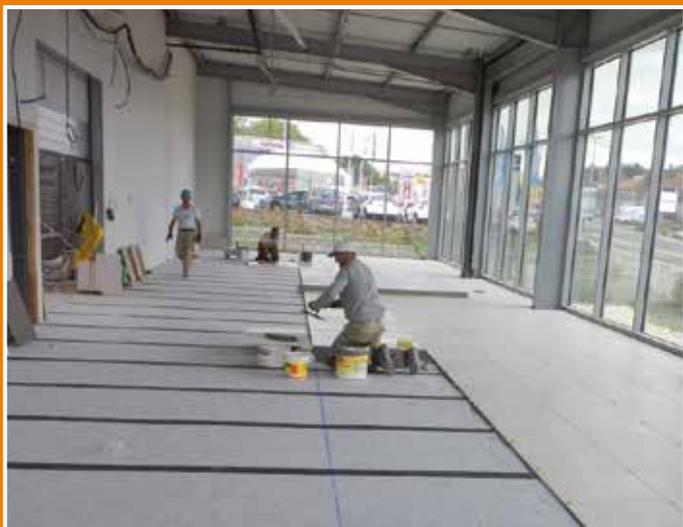
Membrane en désolidarisation sur plancher béton
