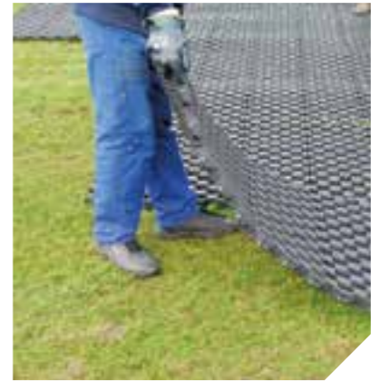
2 POSE DES PLAQUES
