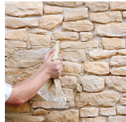
2 - Je réalise les joints
