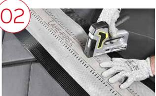
Le recouvrement entre chaque closoir Lahe-first doit être de 5 cm.
