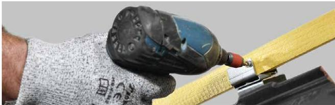
La pose des closoirs en arêtier est réalisée avant celle en faîtage. Le closoir de faîtage devra recouvrir celui de l'arêtier sur toute sa largeur. Le closoir Lahe First doit être adapté à la tuile sur laquelle il sera posé (classe G0, G1 ou G2).
