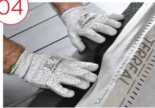
Maroufler manuellement les bavettes du closoir Lahe-first, du sommet du galbe de la tuile (couvert) vers le creux des tuiles (courant). Bien presser les bandes adhésives contre les tuiles. En cas de fort galbe, étirer la bavette avant de maroufler afin d'obtenir l'adaptabilité maximum du closoir. Le butyle doit être en contact avec la tuile sur toute sa longueur et toute sa largeur. Les bavettes doivent recouvrir la tuile de 10 cm (ou 8 cm en creux d'onde pour les tuiles galbées).
