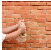
2 - Je réalise les joints
