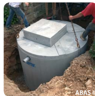
Largeur de la fouille : 3,0x3,0 m - SB 4/5/6
