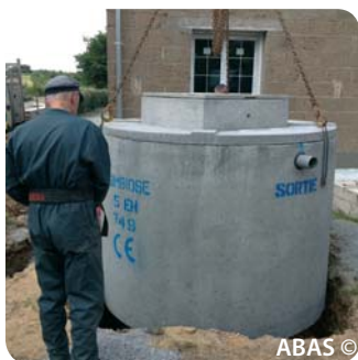
Accès libre autour du fond de fouille
