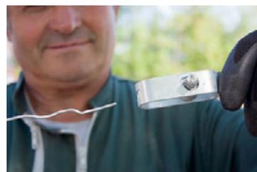
**Tendre des fils de tension de chaque côté du support pour venir fixer la brande en « sandwich ».** Utiliser des jambes de force en fer en L, à fixer de chaque côté de la clôture à chaque extrémité et à chaque angle.
