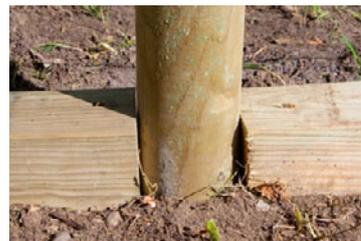
Mise en place d'un soubassement fortement conseillé soit un madrier, plaque standard béton etc.
