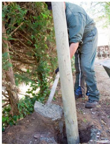
Scellement des poteaux obligatoirement dans un plot béton, mis d'aplomb, de niveau et parfaitement aligné.
