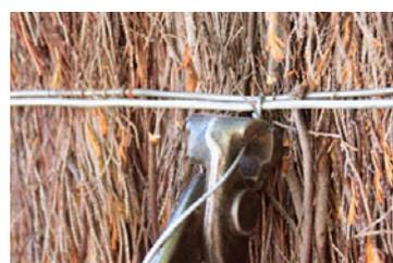
**Présenter les panneaux de brande idéalement à 2 personnes, attacher au support afin que la clôture ne fasse qu'un.** Le travail d'attache est long mais indispensable à la durée de vie de votre clôture. Pour finir taper sur la tête de clôture afin d'obtenir un horizon parfait.
