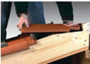
La longueur du versant déterminera l'emploi de la tuile sous-faîtière (1 ou 3/4 ou 1/2 pureau). Détail de pose «à la lyonnaise» avec découpe du bandeau de rive.
