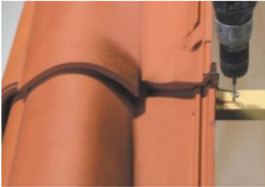
Fixation des tuiles en rive latérale gauche par crochet "V2" réf. CRV02.
