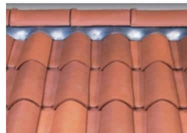
Faîtage réalisé à sec avec faîtières 1/2 rondes à emboîtement grand modèle et closoir ventilé, sans emploi de mortier.
