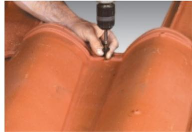
Fixation des tuiles double bourrelet en rive latérale droite par vis et rondelle d'étanchéité
