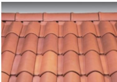
Faîtage réalisé à sec avec tuiles sous-faîtières 1/2 pureau et faîtières 1/2 rondes à emboîtement grand modèle, ne nécessitant pas d'étanchéité complémentaire, sauf protection neige poudreuse
