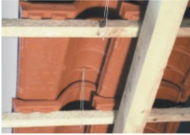
Fixation des tuiles en plain carré pour tenue au vent par pannetonnage.
