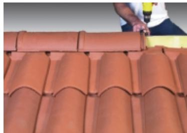
Fixation des faîtières par crochet adapté au modèle, vissé dans lisse de rehausse.
