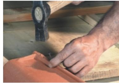
Fixation des rives rondes individuelles à emboîtement en rive latérale gauche et droite par clou.
