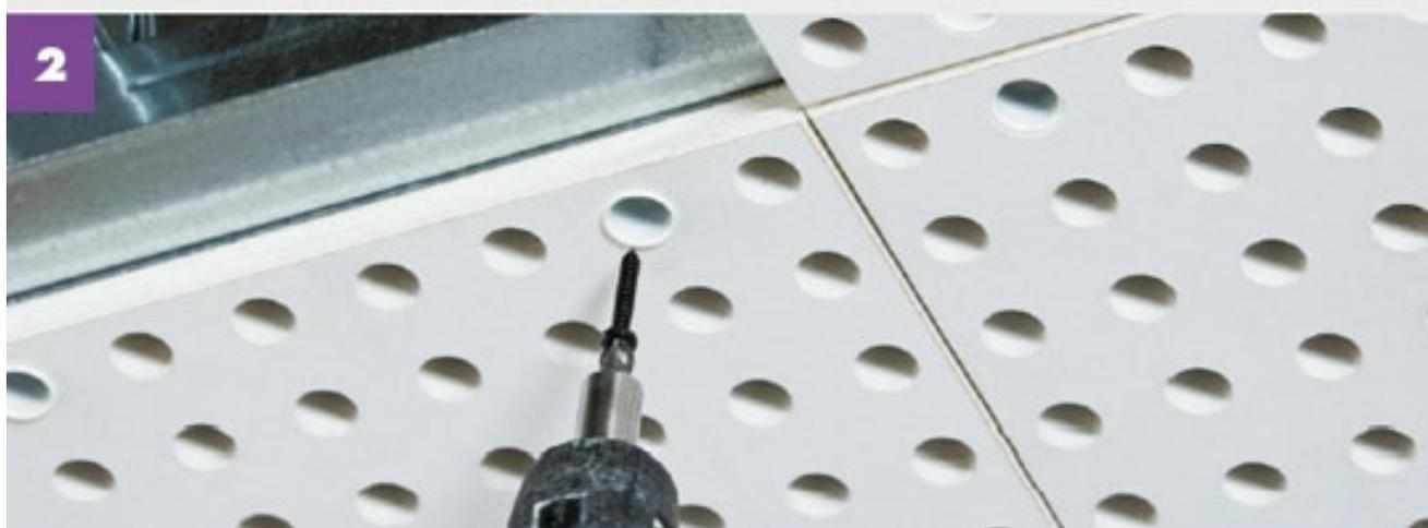
Avec le nouveau plafond Delta Linear, la plaque dispose d'un bord décroché qui reste nu. Elle est ensuite fixée par une vis qui s'insère dans un capuchon, lui-même installé dans la perforation et qui épouse parfaitement sa forme. Il est donc inutile de procéder à la reprise d'enduisage de la tête de vis car elle est invisible.
