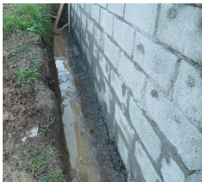
FIGURE N°5 : REJOINTOIEMENT DES PAREMENTS DES FONDATIONS
