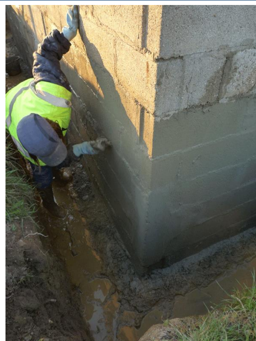
FIGURE N°11 : MISE EN ŒUVRE D'UN PRODUIT D'ETANCHEIFICATION
