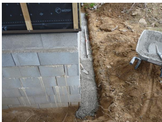
FIGURE N°8 : REALISATION DE LA CUNETTE EN BETON MAIGRE & VERIFICATION DES PENTES
