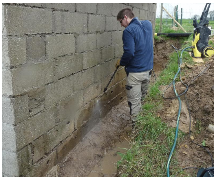
FIGURE N°4 : DECAPAGE DES SURFACES A L'AIDE D'UN NETTOYEUR HAUTE PRESSION
