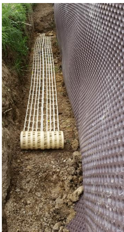
FIGURE N°27 : MISE EN ŒUVRE D'UN GRILLAGE AVERTISSEUR
