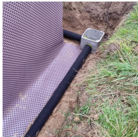
FIGURE N°18 : CHANGEMENT DE DIRECTION AVEC UNE BOITE D'INSPECTION
