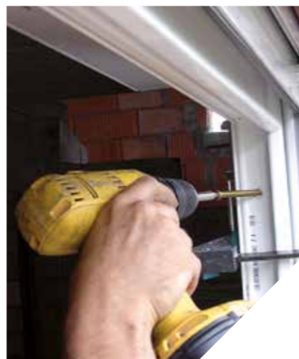
Exemple de fixation à travers le profilé
