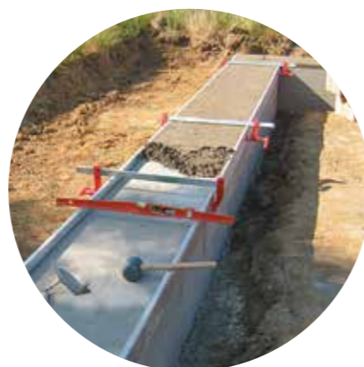
Arasement du mortier sur longrines. Retirer les règles avant pose du 1 er rang de briques.
