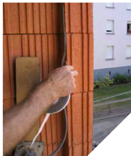
Pose du joint de calfeutrement pré-comprimé et pré-imprimé
