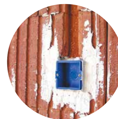
Boîtier électrique posé au plâtre
