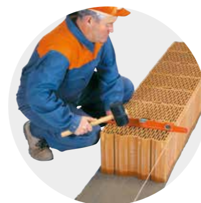
Pose du premier rang sur mortier d'arase frais
