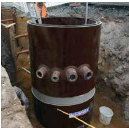
Regard spécial DN 1200 avec raccords pour conduites sous pression dans la rehausse
