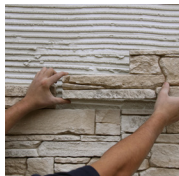
1 - Je pose en faisant baver la colle
