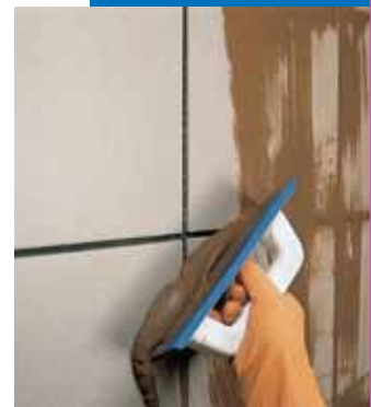
Jointoiment en façade à l'aide d'une spatule
