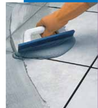
Jointoiment de carrelage en sol à l'aide d'une spatule caoutchouc
