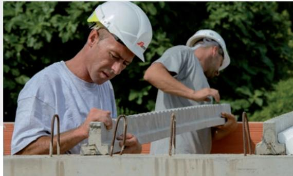
■ La pose débute par les poutrelles. Démarrer en début de travée avec l'obturateur pour régler l'entraxe des poutrelles.
