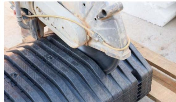
■ La découpe transversale s'effectue sur le bas de la nervure.
