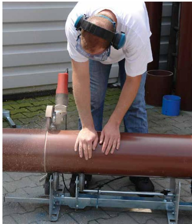
Tronçonnage à la longueur souhaitée et chanfreinage simultané du tube
