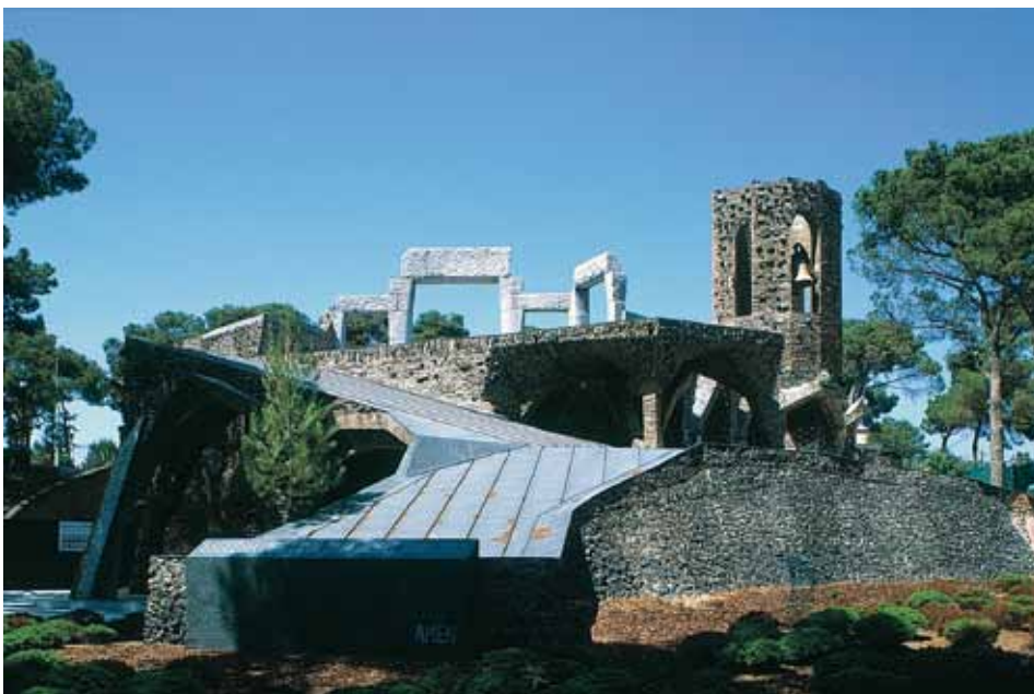
Crypte, Barcelone (Espagne) - Architecte : Servicios Technicos Diputacion Barcelona, A. Gonzalez - Entreprise : Forja Capellas
