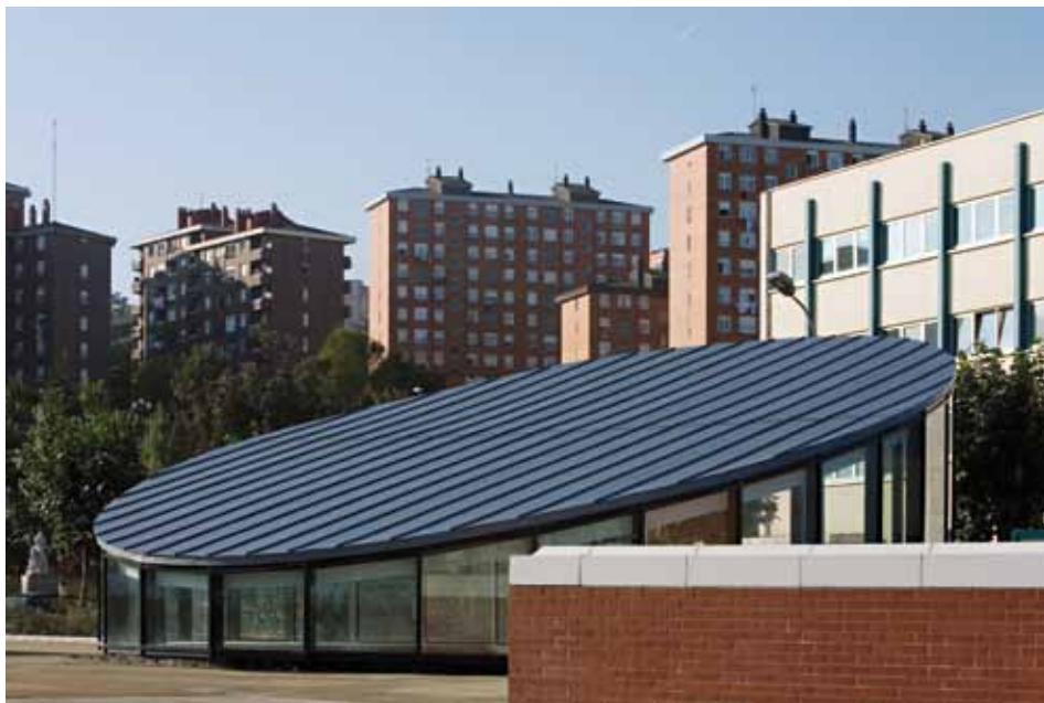
Université, Santander (Espagne) - Architecte : Juan Carlos Ruiz Moncalean - Entreprise : Tesico
