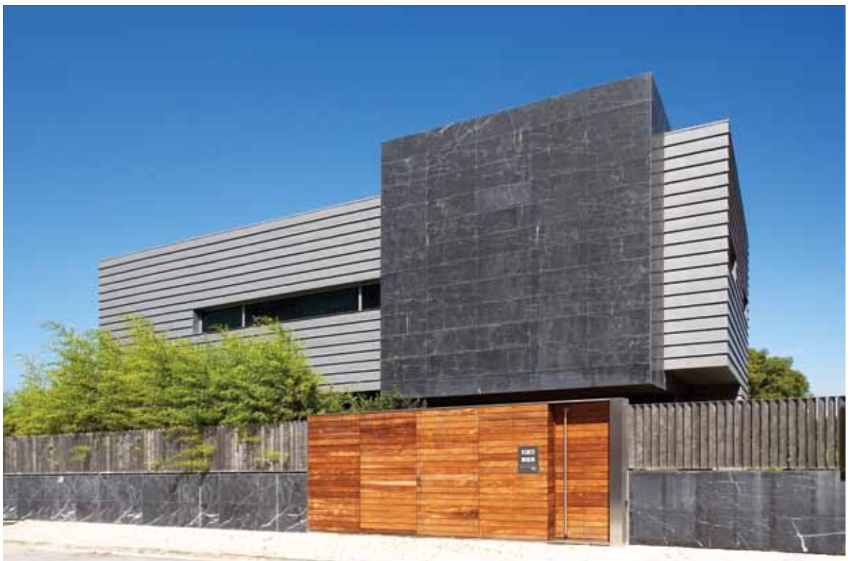
Maison individuelle, Lisbonne (Portugal) - Architecte : Arquitecto Pedro Martins - Entreprise : Umicore Portugal SA
