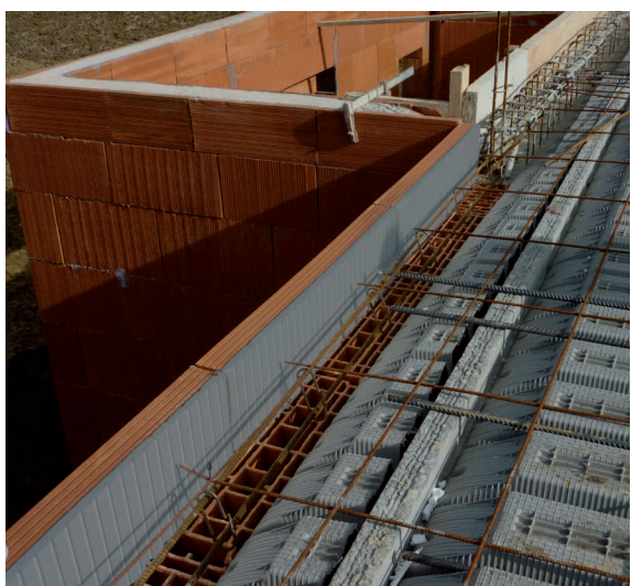
Plancher bas sur terre-plein avec dalle pleine
