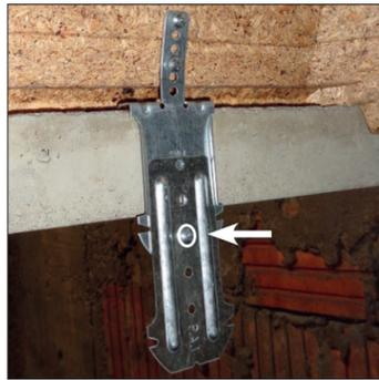
Après réglage de la hauteur du faux plafond, visser la suspente courte (rallonge) à l'aide d'une vis\*.
