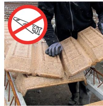
**3** DECOUPE DU DERNIER MODULE PAR SIMPLE PRESSION
