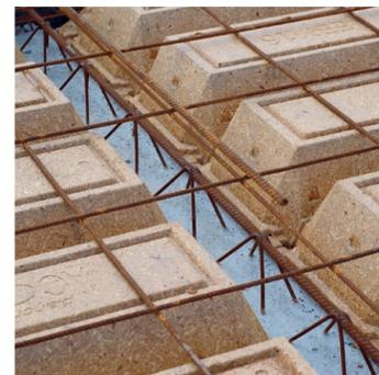
**5** ETAIEMENT SI NECESSAIRE PUIS FERRAILLAGE
