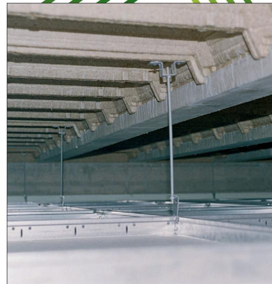
La suspente OMEGA peut se fixer sur la totalité de la sous-face de l'EBM.
