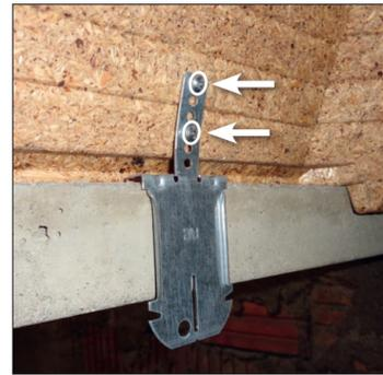
Appliquer la languette contre la sous face de l'EBM, fixer la suspente directement dans l'EBM à l'aide de 2 vis\*, en la maintenant sur le talon de la poutrelle.
