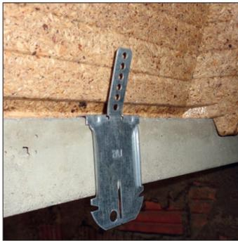
Placer la suspente EBM sur le talon de la poutrelle.
