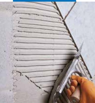
Pose de carreaux sur béton cellulaire
