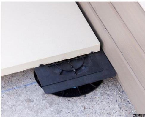
Placer le plot avec la plaque à dalle contre le mur par exemple, et placer la dalle contre les écarteurs de la plaque à dalle. Bien décaler votre plot sous la dalle pour arriver à fleur de la plaque à dalle.
