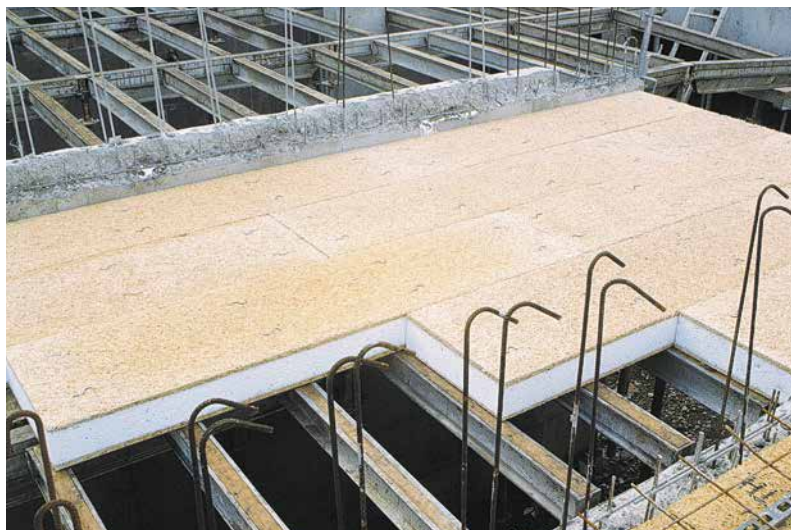
Pose de panneaux agrafés sur coffrage industrialisé
