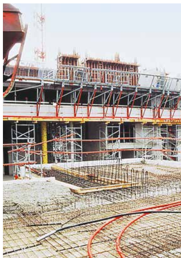
Mise en œuvre en fond de coffrage
