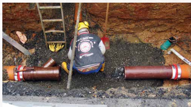
Réparation de conduites défectueuses
