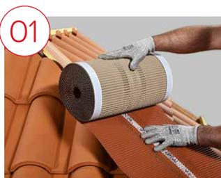
Démarrer la pose du closoir souple Lahe-Roll par l'extrémité basse de la lisse d'arêtier (pour le faîtage, commencer par l'extrémité opposé au sens des vents dominants). Bien centrer le closoir sur la lisse, dernier rang de tuiles doit se trouver à une distance de 1 cm de la lisse ou bois de rehausse.
