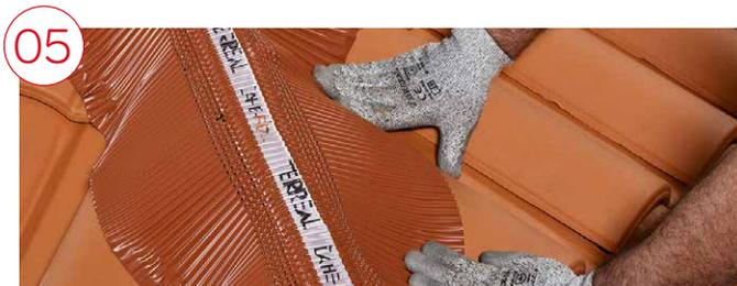
Maroufler manuellement les bavettes du closoir Lahe-Roll, du sommet du galbe de la tuile (couvert) vers le creux des tuiles (courant). Bien presser les bandes adhésives contre les tuiles. En cas de fort galbe, étirer la bavette avant de maroufler afin d'obtenir l'adaptabilité maximum du closoir. Le butyle doit être en contact avec la tuile sur toute sa longueur et toute sa largeur. Les bavettes doivent recouvrir la tuile de 10 cm (ou 8 cm en creux d'onde pour les tuiles galbées).
