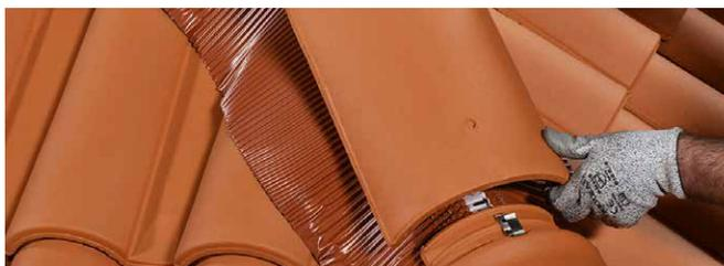
À l'extrémité du faîtage ou de l'arêtier, couper le closoir souple Lahe-Roll avec des ciseaux ou un cutter. La chute peut être réutilisée lors d'un prochain chantier.
