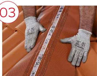
Plier le closoir LAHE-ROLL sur les tuiles en se servant des plis préformés et comprimer la bavette uniformément dans le courant des tuiles des 2 côtés de la rehausse. Veiller à ne pas trop presser la partie centrale perforée sur la rehausse afin de ne pas diminuer la capacité de ventilation.
