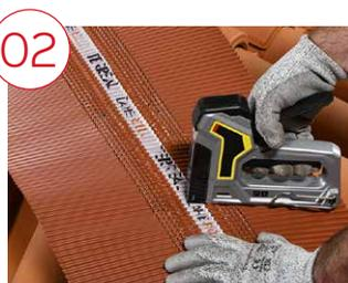
Le recouvrement entre chaque closoir Lahe-Roll doit être de 5 cm.
