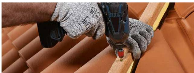
La pose des closoirs en arêtier est réalisée avant celle en faîtage. Le closoir de faîtage devra recouvrir celui de l'arêtier sur toute sa largeur. Le closoir Lahe Roll doit être adapté à la tuile sur laquelle il sera posé (classe G0, G1, G2 ou G3).
