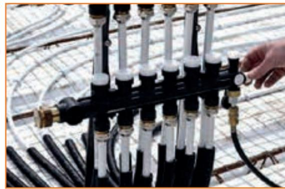
**5** Mise en pression de l'installation à plus de 3 bars. Pose du ferrillage complémentaire et coulage de la dalle de compression.
