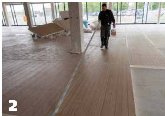
2 Les panneaux sont mis en place en partant d'un angle du mur opposé à l'entrée de la pièce, feuilures apparentes vers l'intérieur de la pièce et feuilures non visibles arasées le long des murs, de façon à présenter un bord droit en appui sur la bande périphérique. Les derniers panneaux aux extrémités sont coupés 3 à 5 mm plus larges et emboîtés en force.
