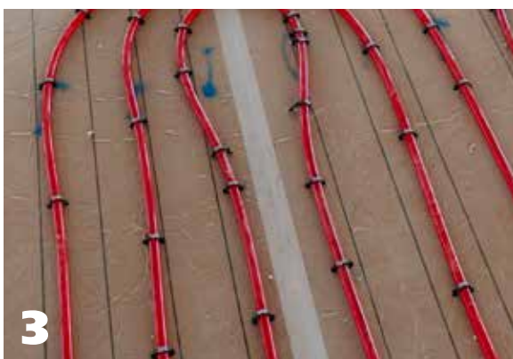
3 Appliquez les flexibles du chauffage par le sol à l'aide de l'agrafeuse et d'agrafes IKOFIX.
