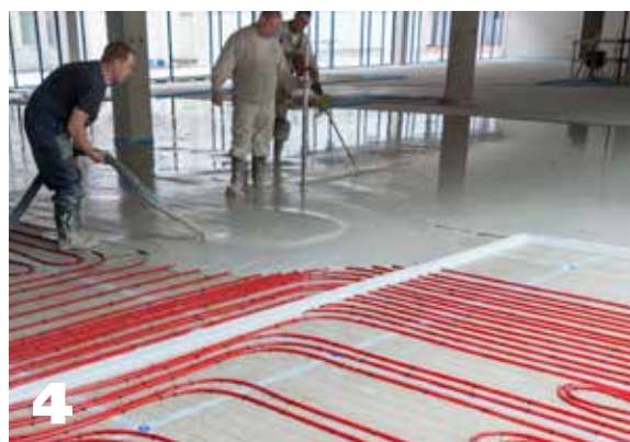
4 Appliquez la finition de sol (chapes, dalles désolidarisées ou flottantes...).
