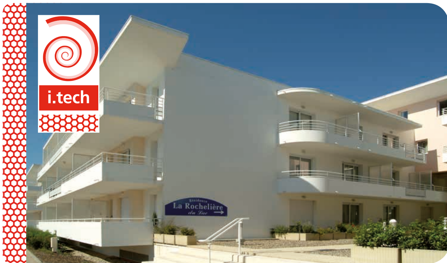
Logements La Rochelière (17) - Architecte : David Michel.
