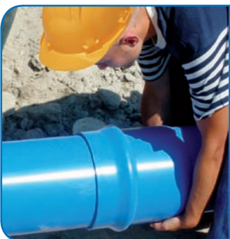
Exercer une poussée sur le bout mâle pour l'introduire dans la tulipe jusqu'à la marque.
