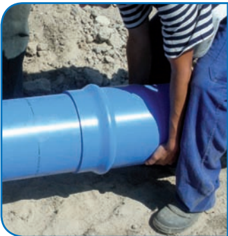
Aligner les tubes et introduire le chanfrein dans l'entrée de la tulipe.
