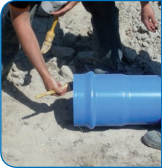
Appliquer le gel lubrifiant sur le chanfrein du bout mâle et sur le joint de la tulipe.
