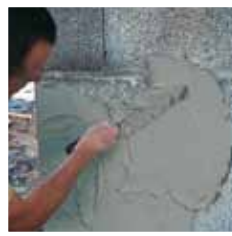
Réalisation d'un sous-enduit
