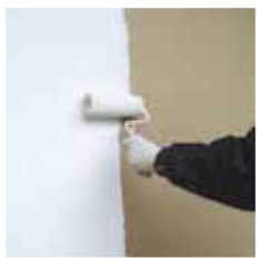
Application du PRB CRÉPIFOND G
