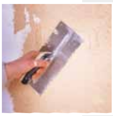
Application du PRB CRÉPIMUR au plâtreur inox
