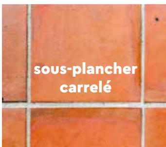
**Vérifiez le plancher pour détecter la présence de problèmes d'humidité.** Ne superposez en aucun cas les joints des lames Spirit Home 40 Click Comfort sur ceux du carrelage existant. Il n'est pas nécessaire de combler les joints d'un carrelage existant si ceux-ci ne dépassent pas 5 mm de large. Rappelez-vous que certains carrelages peuvent présenter des parties saillantes bien que le nivellement général soit correct. Ces aspérités peuvent se voir au travers du nouveau revêtement.
