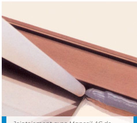
Jointoiement avec Mapesil AC de fenêtre en aluminium
