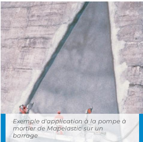
Exemple d'application à la pompe à mortier de Mapelastic sur un barrage
